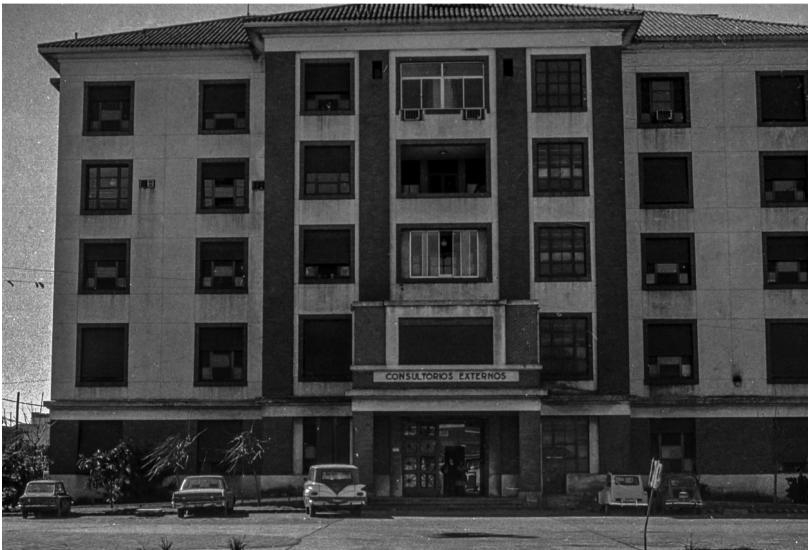
Entrada al Consultorio Externo del Servicio de Psicopatología y Neurología de Lanús
